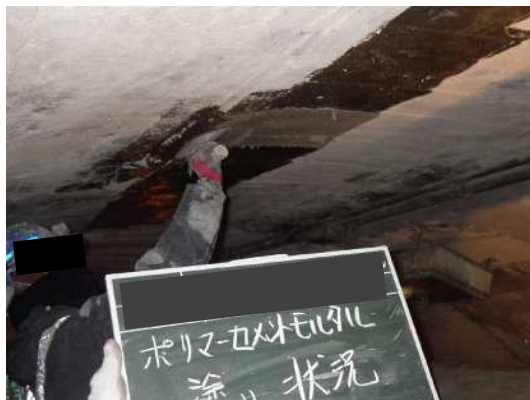
写真-7 断面修復工状況(塗布-左官)
