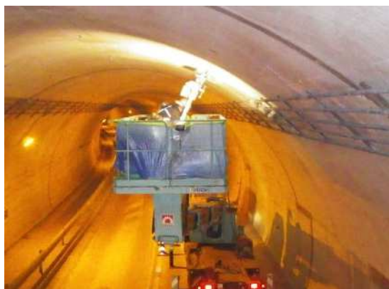
写真-5 空洞充填工状況(注入孔削孔)
