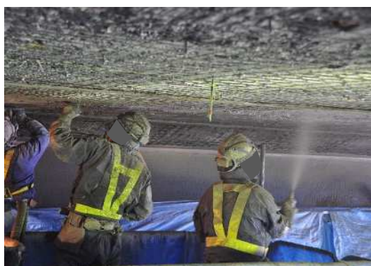
写真-11 断面修復工状況(乾式吹付け)
