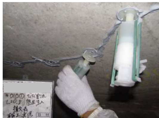
写真-8 ひびわれ注入工状況(低圧注入)
