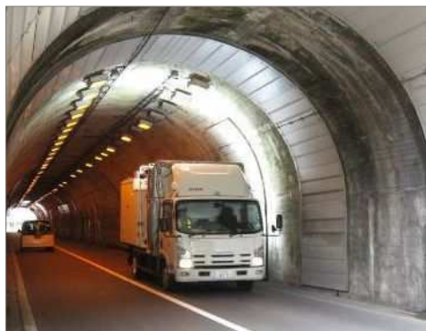
写真-23 走行型画像計測車による 壁面画像計測
