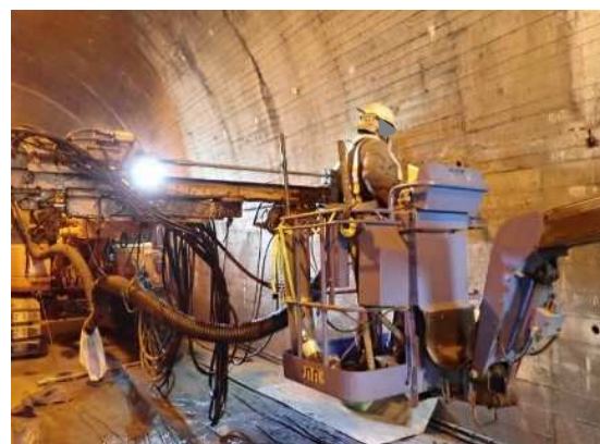
写真-10 ロックボルト工状況(削孔)
