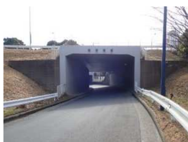
写真-3 開削工法 (平和隧道)
