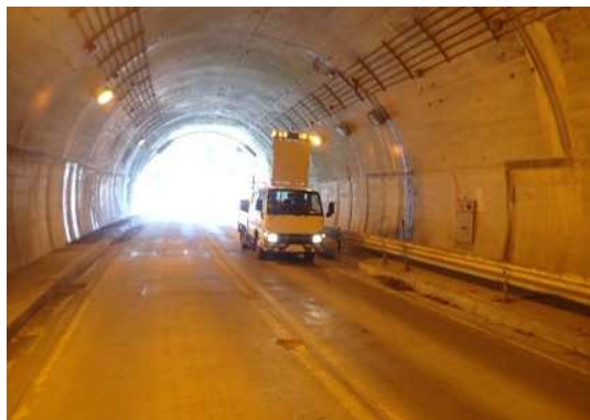
写真-13 日常点検の実施状況
