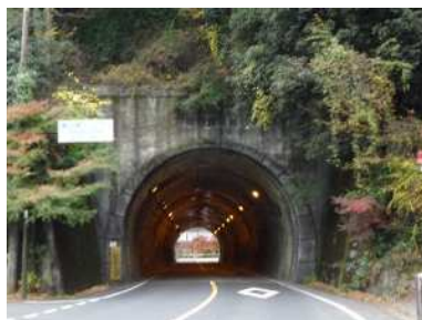
写真-2 在来工法(矢板工法) (鳩の巣トンネル)
