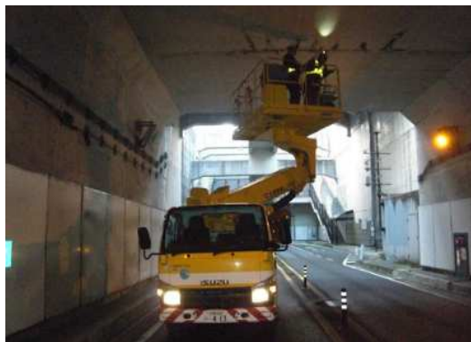
写真-14 定期点検の実施状況(近接目視)
