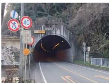
写真-1 NATM(標準工法) (新満地トンネル)
