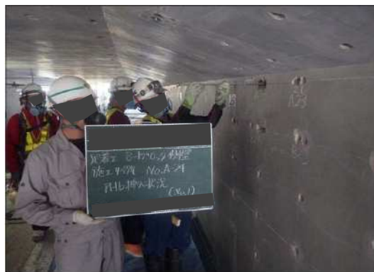
写真-12 せん断補強鉄筋設置状況(鉄筋挿入)
