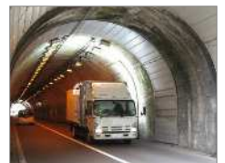
走行型画像計測車 による壁面画像計測
