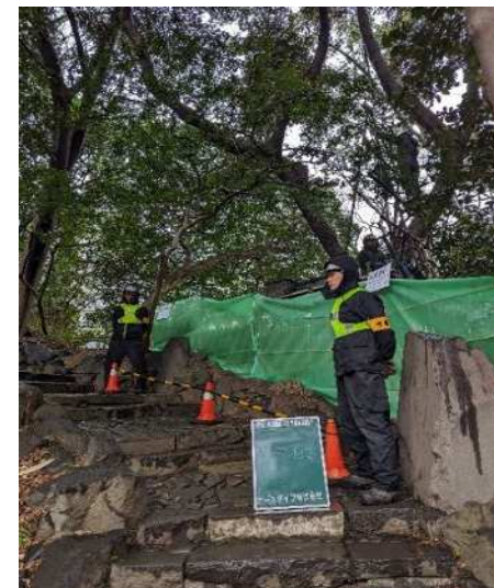
景観に配慮した仮設物の設置状況（B型バリケード＋緑ネットの設置）
