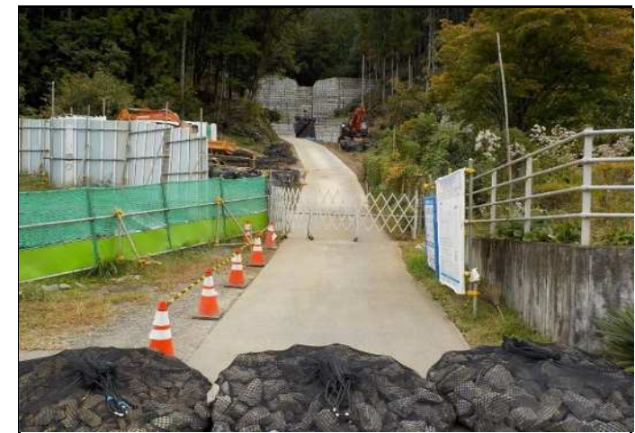
袋詰め玉石設置状況
