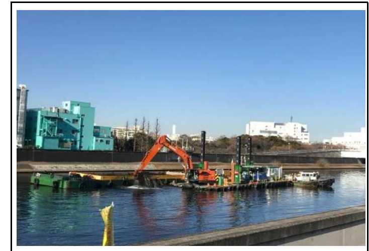
しゅんせつ作業
