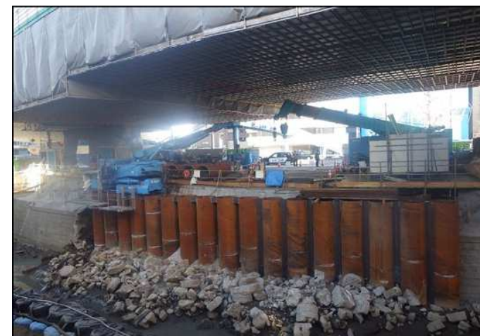
施工ヤード内クレーン作業状況（首都高足場近接）
