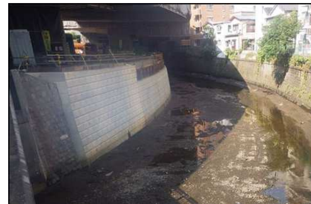
施工後（下流側）
