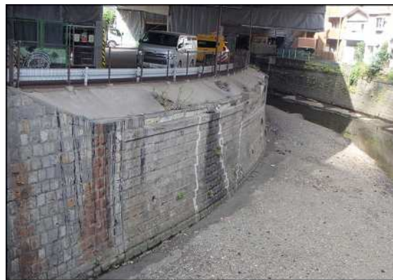
施工前（下流側）
