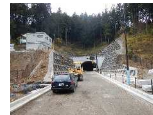
道路照明灯据付
