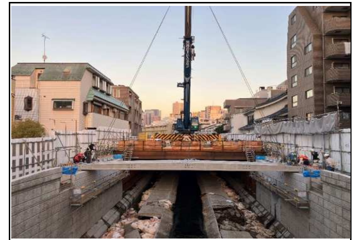
本郷橋 桁架設状況
