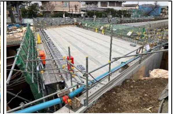
神通橋 施工後
