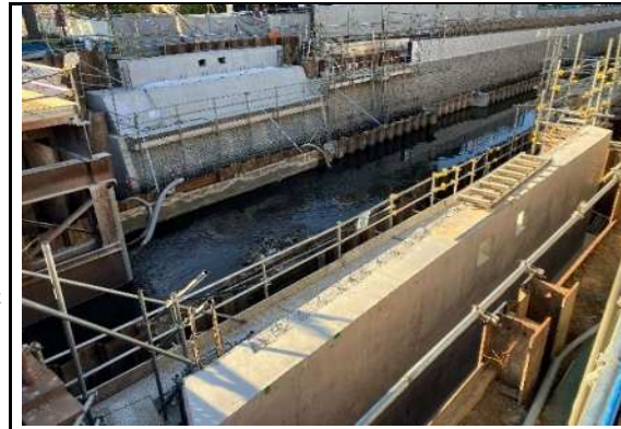
神通橋 施工前
