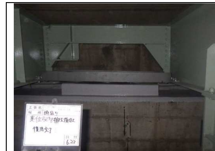
変位制限装置撤去復旧工（復旧完了）
