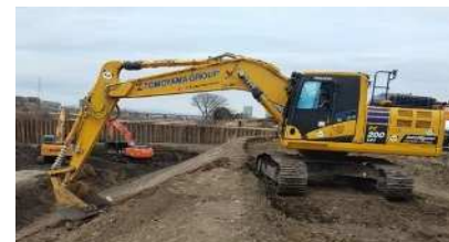
ICT技術の活用した法面整形状況
