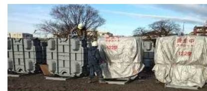
根固めブロック製作でコマシートシルバー（温度変化対策）を使用したコンクリート養生状況
