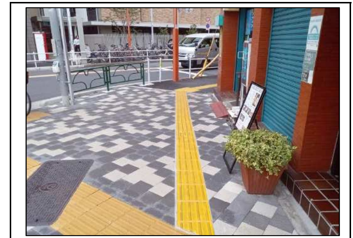
地元調整を密に行いながら施工した 視覚障害者誘導用標示シート（連続設置）
