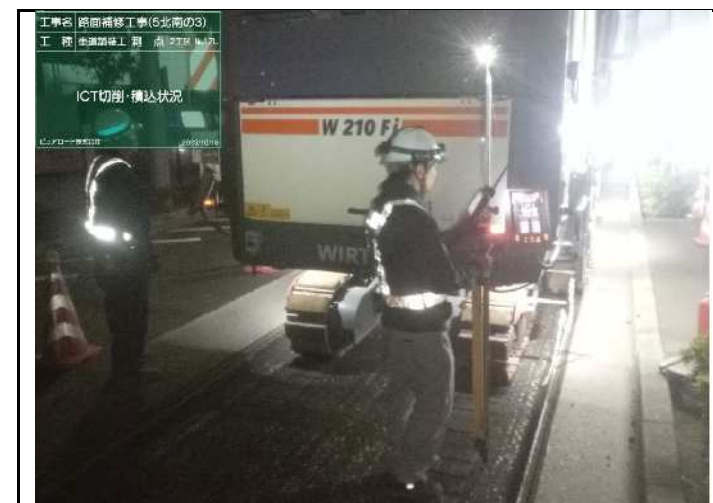
ICT切削・積込状況
