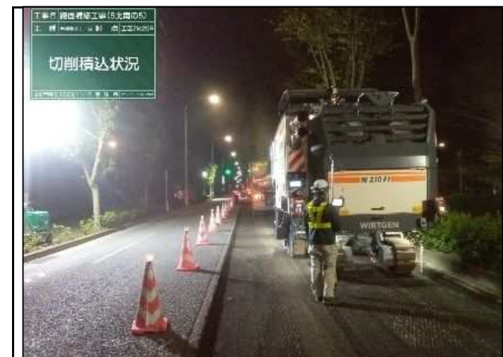
ICT切削・積込状況
