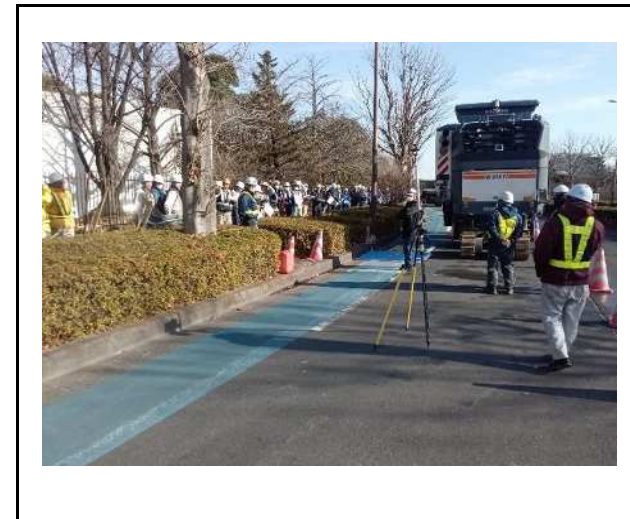
ICT機械施工での見学会(※写真の説明コメント)
