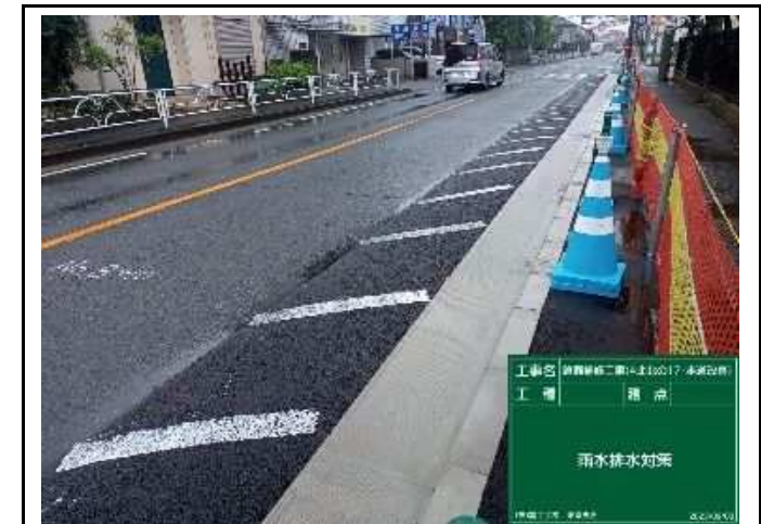
すりつけ舗装（ポーラスAs+端部に窪み）
