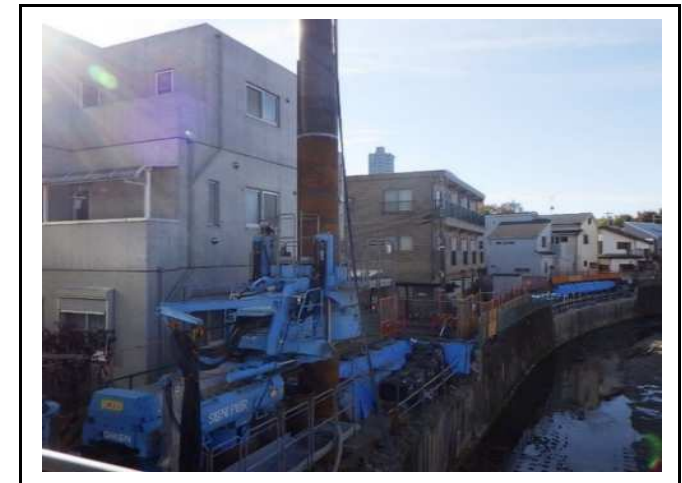
近接する一般家屋脇での鋼管打設作業（右岸側）
