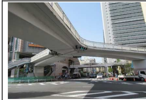
施工前 (歩道橋全景)
