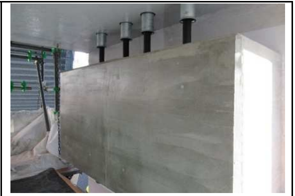
施工後 (施工箇所拡大)
