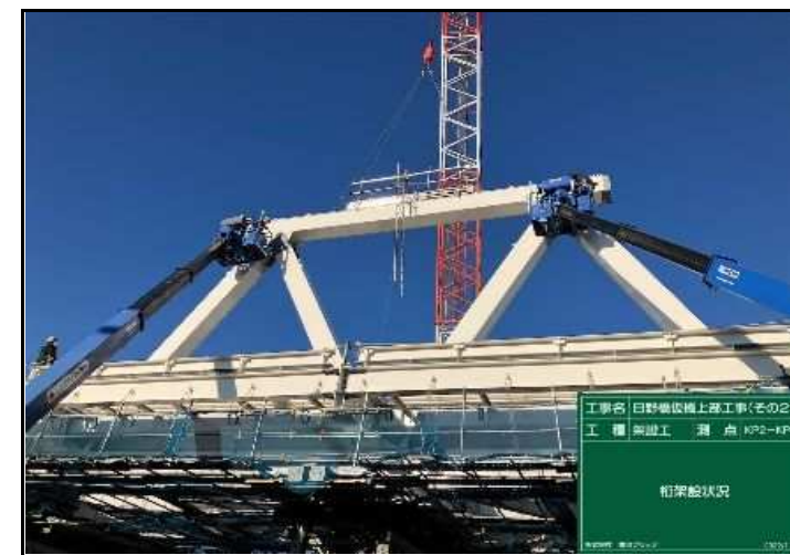
上弦材架設状況
