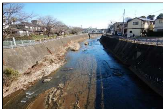
鶴見川コンクリートブロック積護岸
