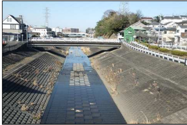
乞田川コンクリートブロック張護岸
