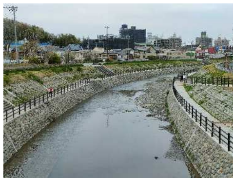
大栗川 新堂橋下流
