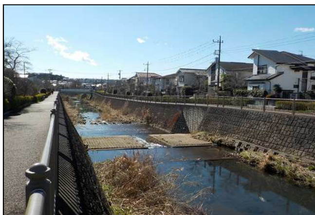
恩田川 床止工・護床工・魚道
