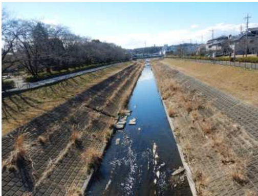
中和田橋付近
