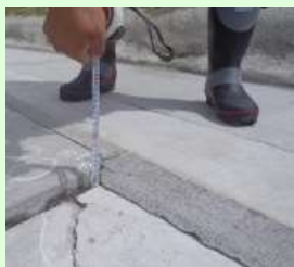
目視点検実施状況
