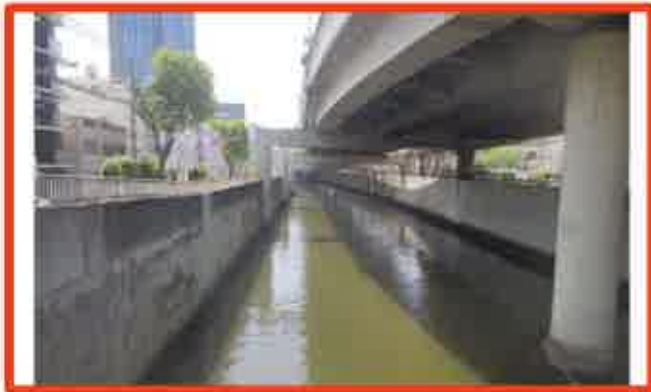
河道整備（護岸整備）本工事にて実施
