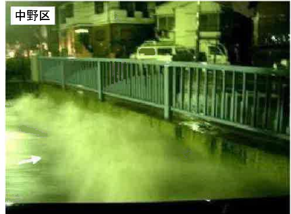
平成 17 年 9 月妙正寺川天神橋
