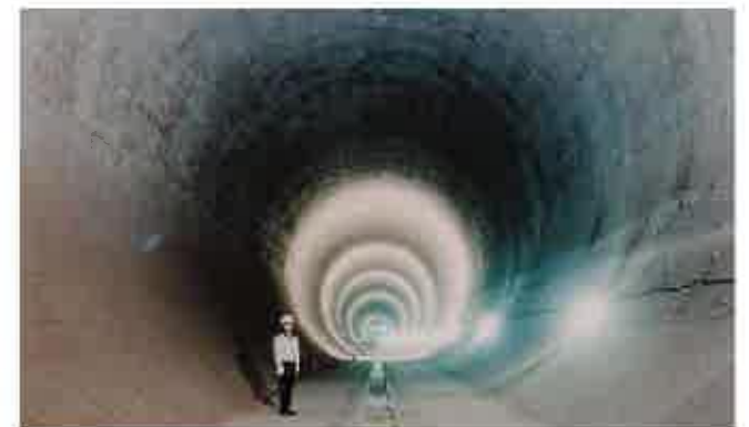
調節池整備（環七地下調節池） （洪水を一時的に貯留する）
