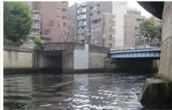
水道橋分水路整備（呑口） （河川沿いにトンネルを作って川の機能を補う）
