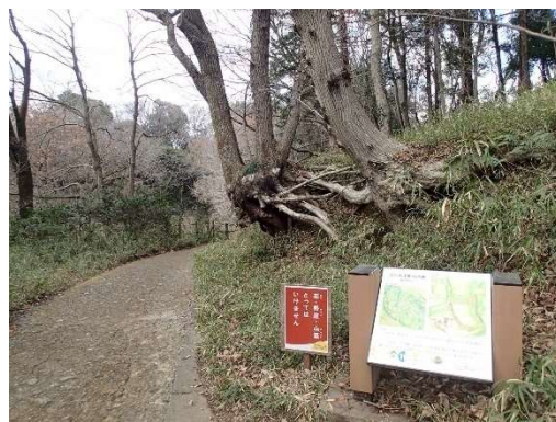
二の丸付近：土砂流出、根が露出
