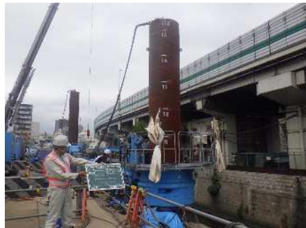
鋼管圧入施工状況※他工事写真
