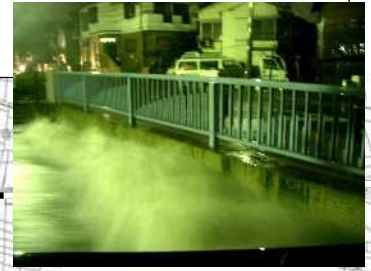
妙正寺川天神橋の様子
