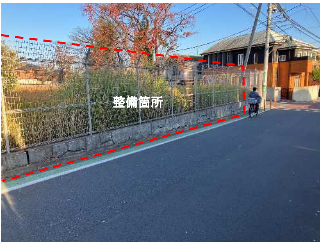
写真①：共立女子学園西側道路より
