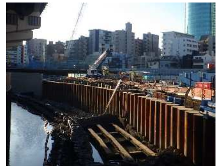
鋼管圧入完了状況※他工事写真
