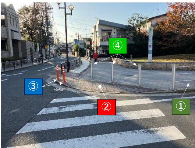
写真① : UR公園南側交差点（西側(西田端橋)方面撮影)
