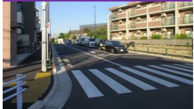
交通開放後の補助第54号線(上祖師谷)の様子
