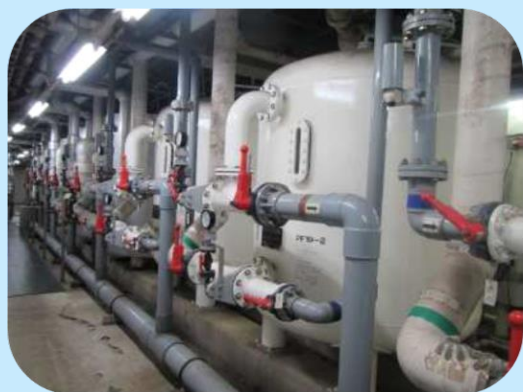
ろ過タンクが密接して配置
