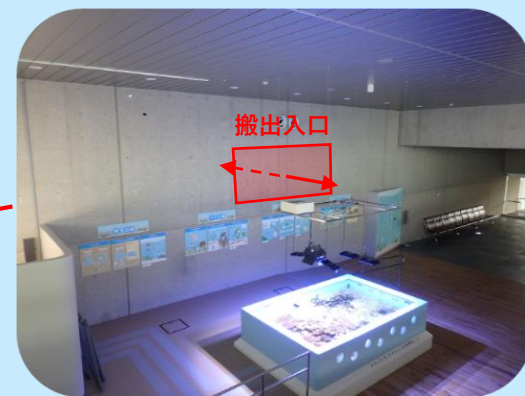
機械室内の設備更新には観覧ルートを通る必要があるため、その都度観覧エリアの閉鎖が必要
