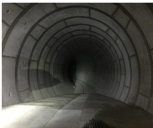
写真 2-7 古川地下調節池内部
