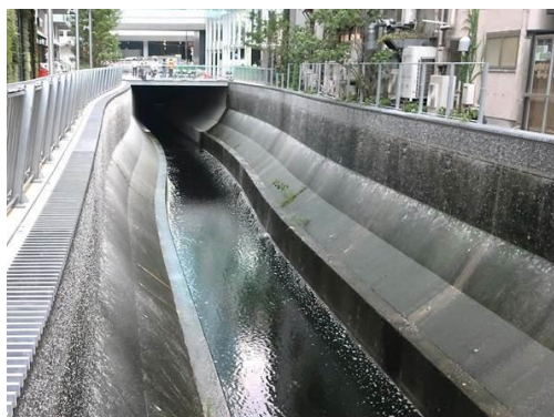
写真2-13 稲荷橋下流付近
