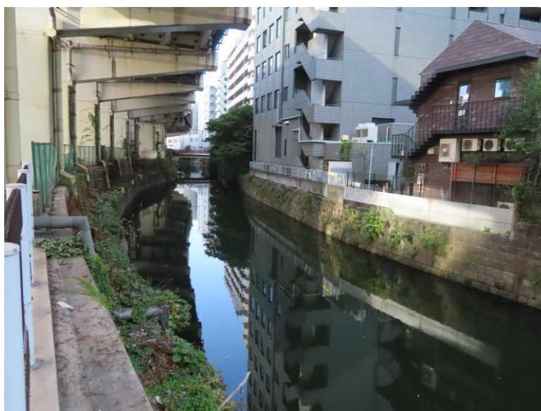
写真 2 - 10 古川沿川のビル・高速道路の状況
