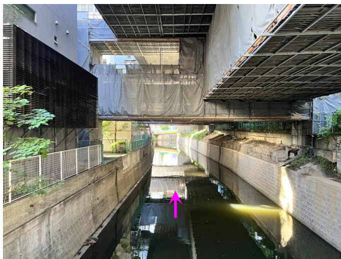
写真4-3 二之橋付近 現況写真
