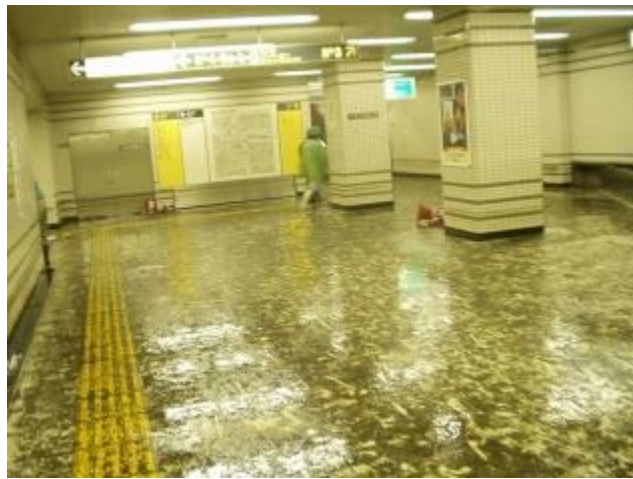
写真 2-2 平成 16 年 10 月 9 日台風 22 号による地下鉄南北線麻布十番駅 コンコース広場の浸水状況
