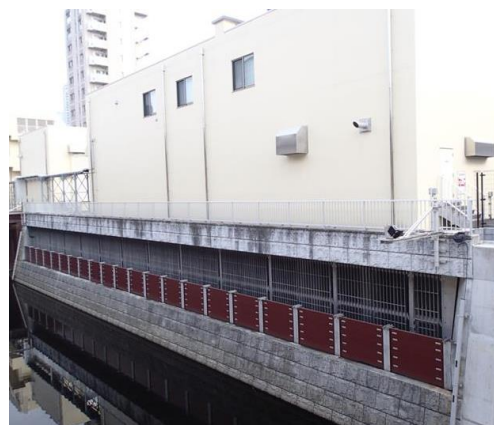
写真 2-8 養老橋下流右岸取水口
