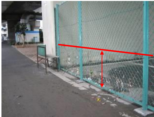
写真 2-1 平成 11 年 8 月 29 日集中豪雨による冠水痕跡（古川橋上流・明治通り）
