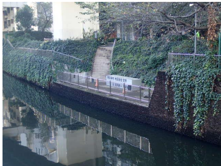
写真 2 - 6 古川（新広尾公園）整備状況
