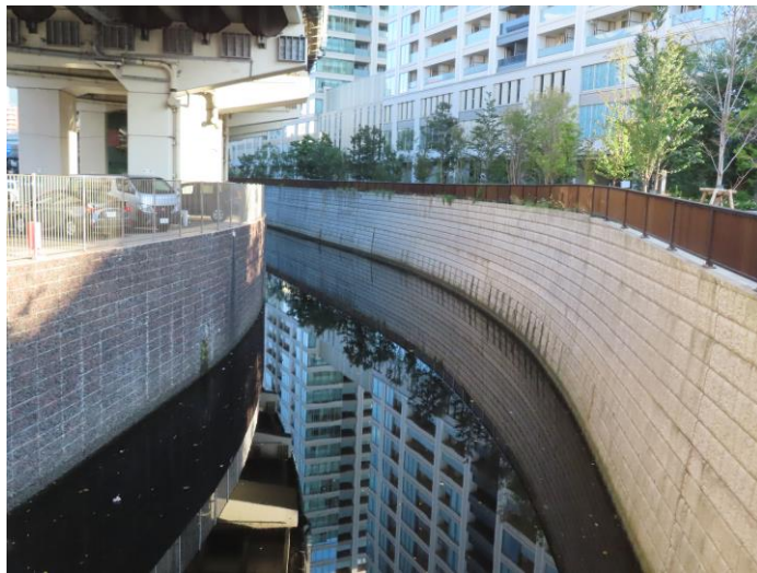
写真 2 - 5 古川（新古川橋下流）整備状況
