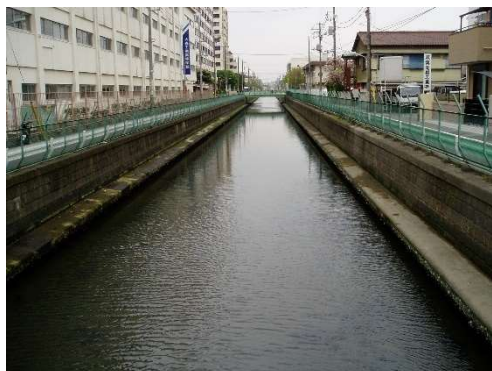
写真 2-4 直壁護岸状況（四之橋上流）
