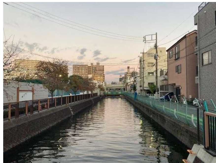
河川の状況(諏訪橋下流)
