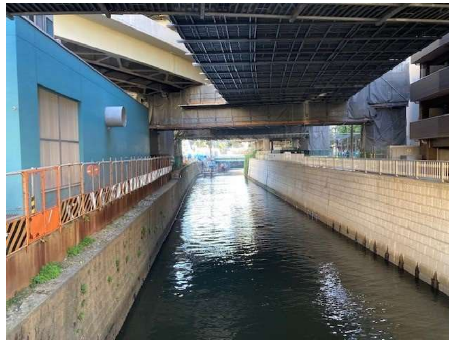
河川の状況(一之橋上流)
