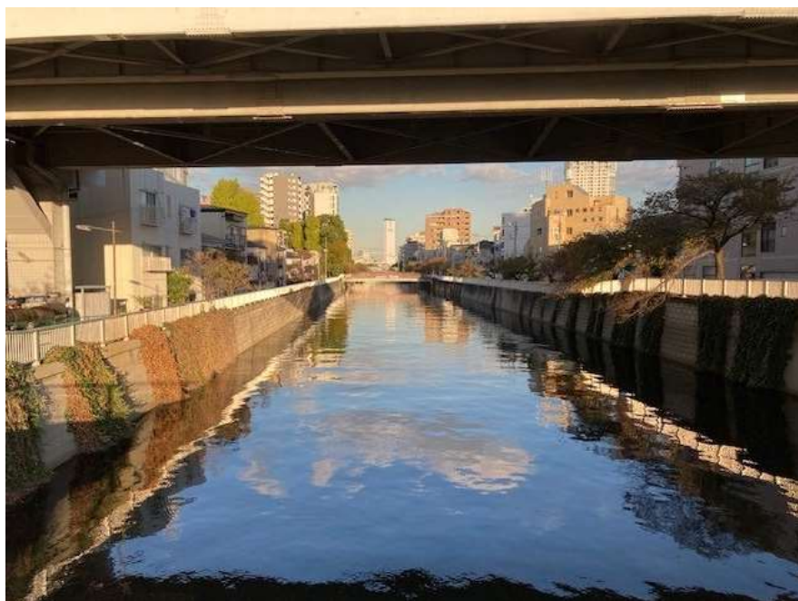
河川の状況(東海橋下流)
