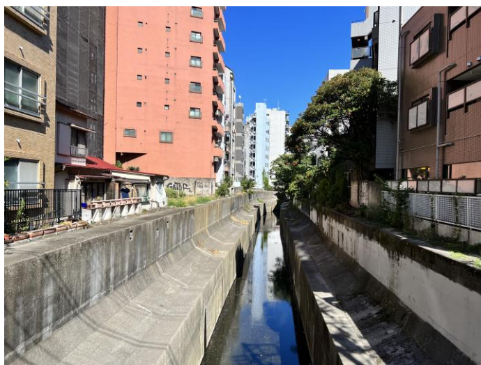
写真 2－4 渋谷川（山下橋付近）整備状況
