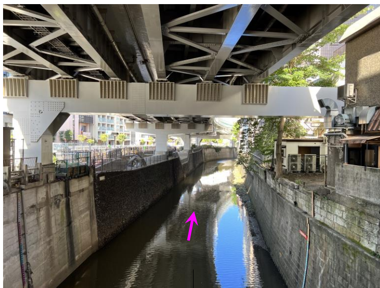
写真 4－2 新古川橋付近（四之橋下流） 現況写真
