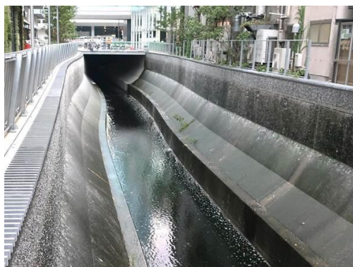
写真2-13 稲荷橋下流付近
