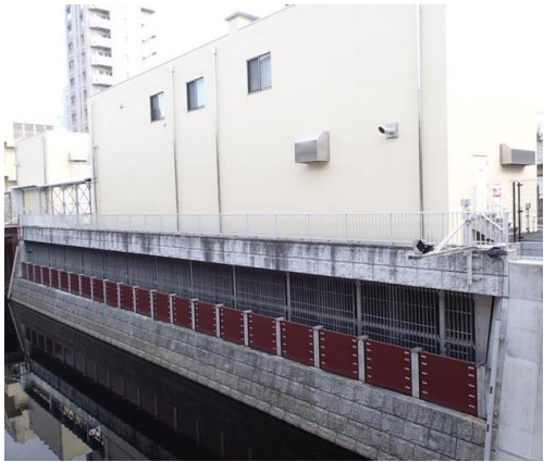
写真 2－8 養老橋下流右岸取水口
