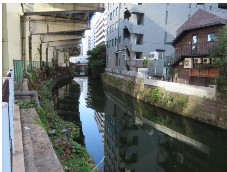
写真 2－10 古川沿川のビル・高速道路の状況
