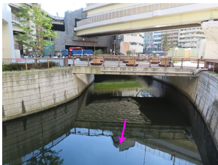
写真4-4 一之橋公園 現況写真
