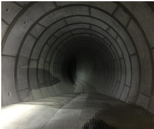
写真 2－7 古川地下調節池内部
