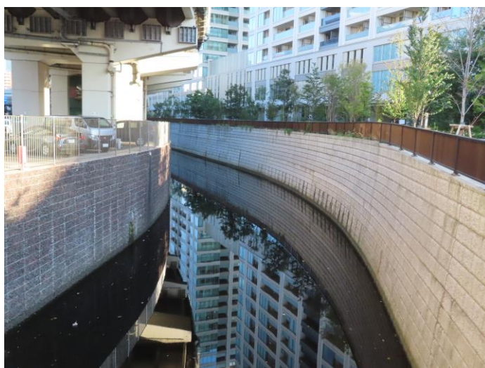
写真 2－5 古川（新古川橋下流）整備状況
