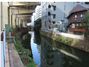
沿川のビル・高速道路の状況（古川）
