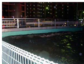
平成16年台風23号（古川橋）
