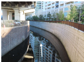
古川 新古川橋付近
