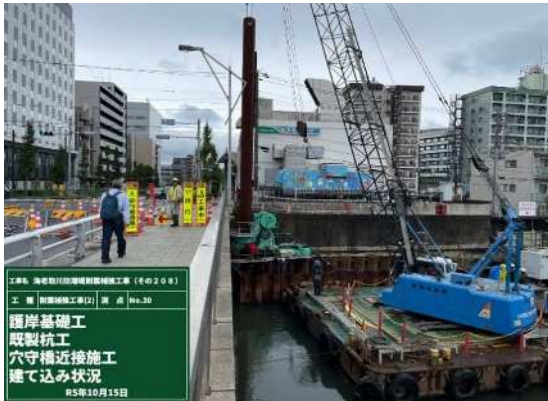
①穴守橋端部鋼管矢板圧入
