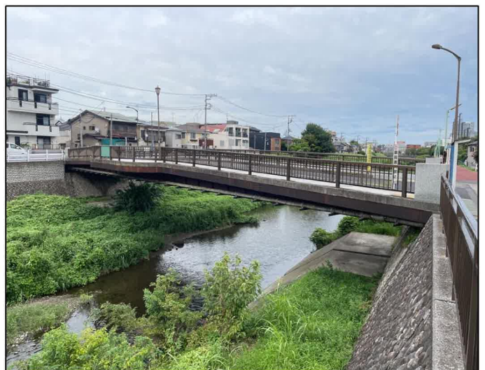
② 野川水道橋
