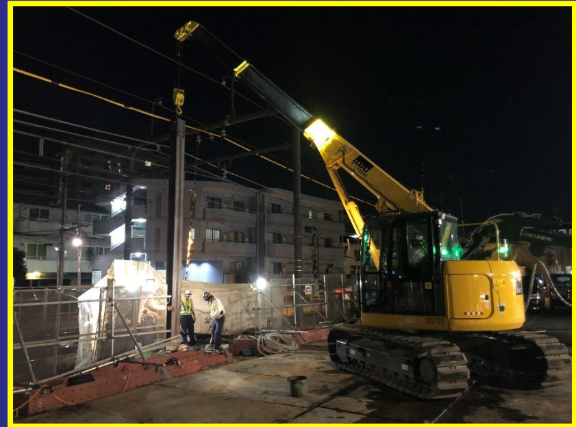
土留杭設置状況 (明大前駅付近)
