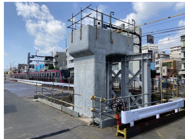
躯体構築状況 (明大前駅付近)
