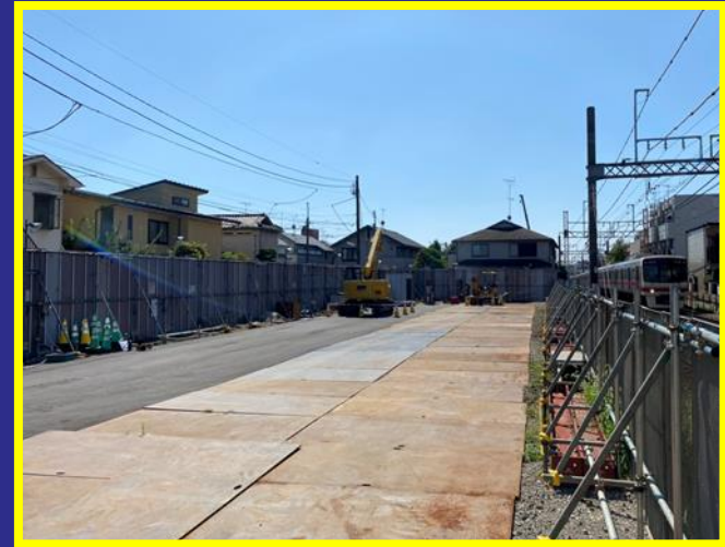
ヤード整備工
