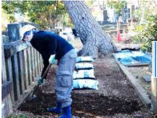
汚染された表土のすき取り
