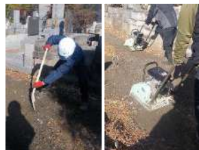
碎石敷均し、転圧状況
