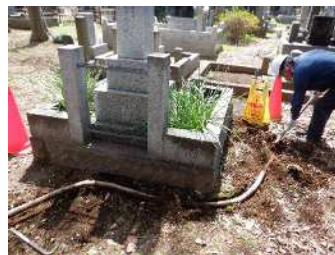
掘り起こして切断
