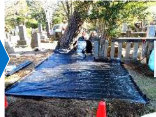
防水シートの敷設
