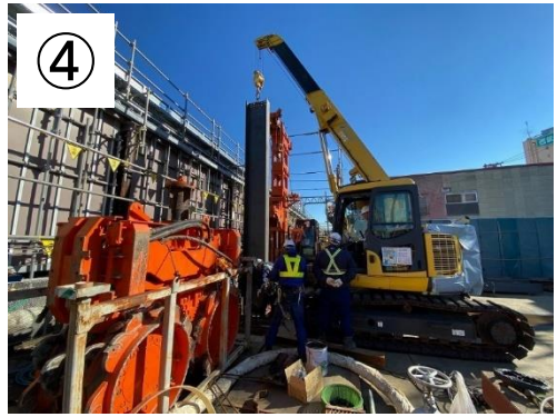
土留打設状況
