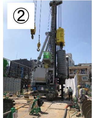
土留打設状況
