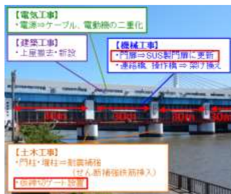
写真-2 耐震補強工事 各工種
