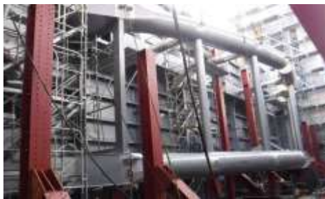
写真-3 仮締切内 門扉組み立て
