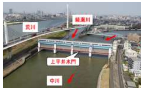
写真-1 上平井水門 全景
