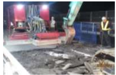
写真—2 I H式舗装撤去 施工状況
