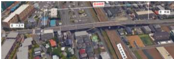
写真－1 豊田陸橋 全景
