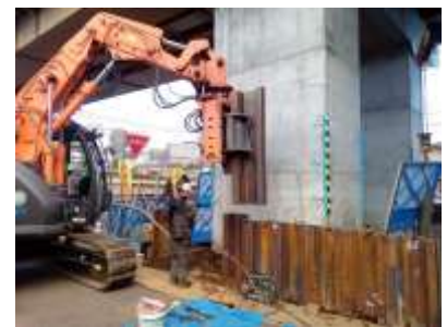
写真—3 耐震補強工 鋼矢板打設状況
