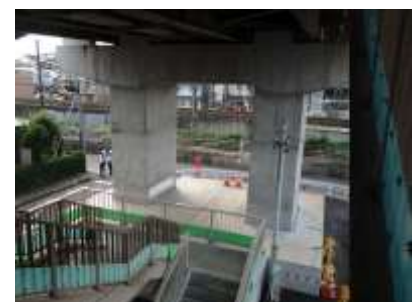
写真—4 耐震補強工 完了状況
