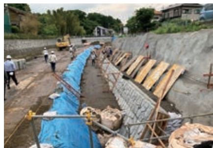
鶴見川 | 河道整備
