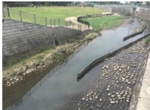
善福寺川 | 親水性の高い緩傾斜護岸
