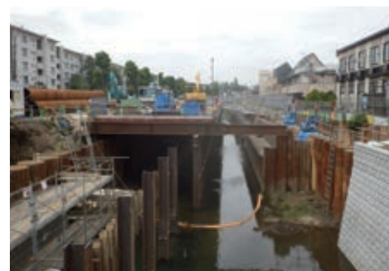
石神井川 | 河道整備
