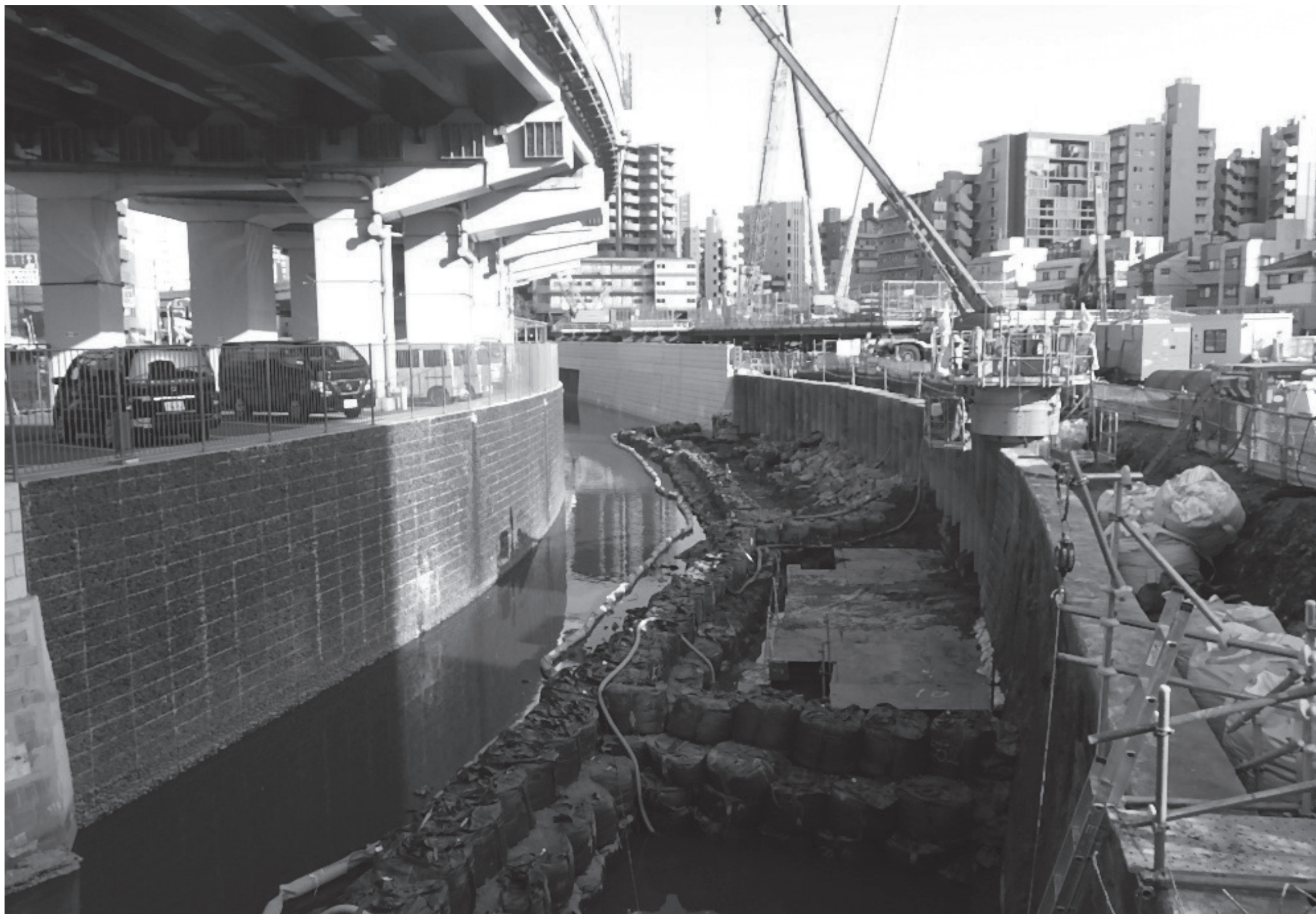
都市部における河道整備（古川）
