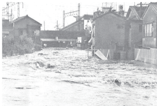
昭和41年6月台風4号 石神井川 王子駅付近
