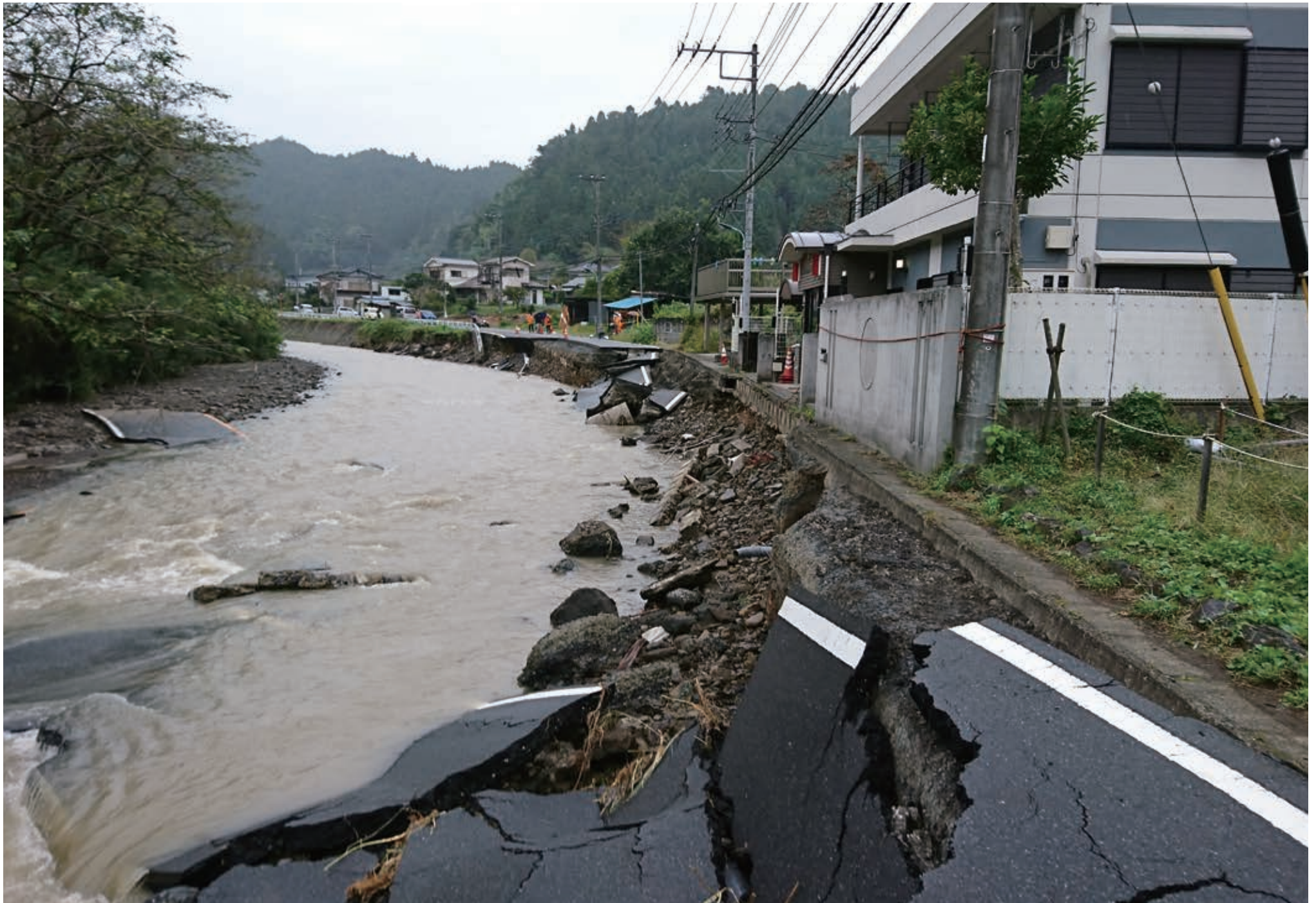
令和元年東日本台風（奥多摩観測所で総雨量 650 mm以上を記録。都管理河川では7河川が溢水、4河川で護岸の崩壊が発生） 写真：平井川
