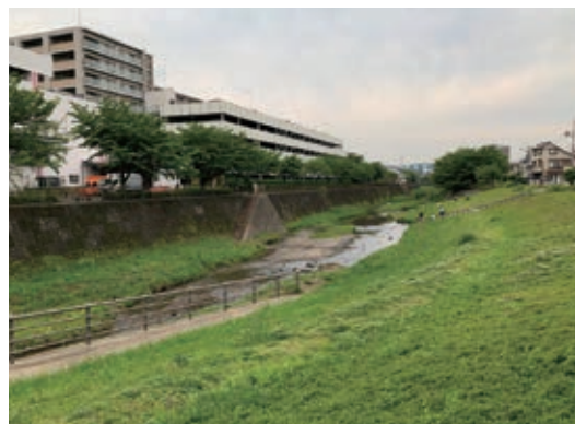
三沢川 | 親水性の高い緩傾斜護岸
