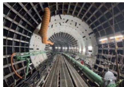
谷沢川 | 分水路の整備
