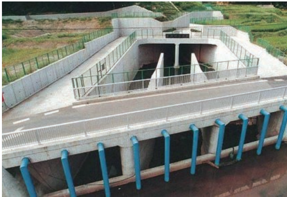
三沢川 | 三沢川分水路
