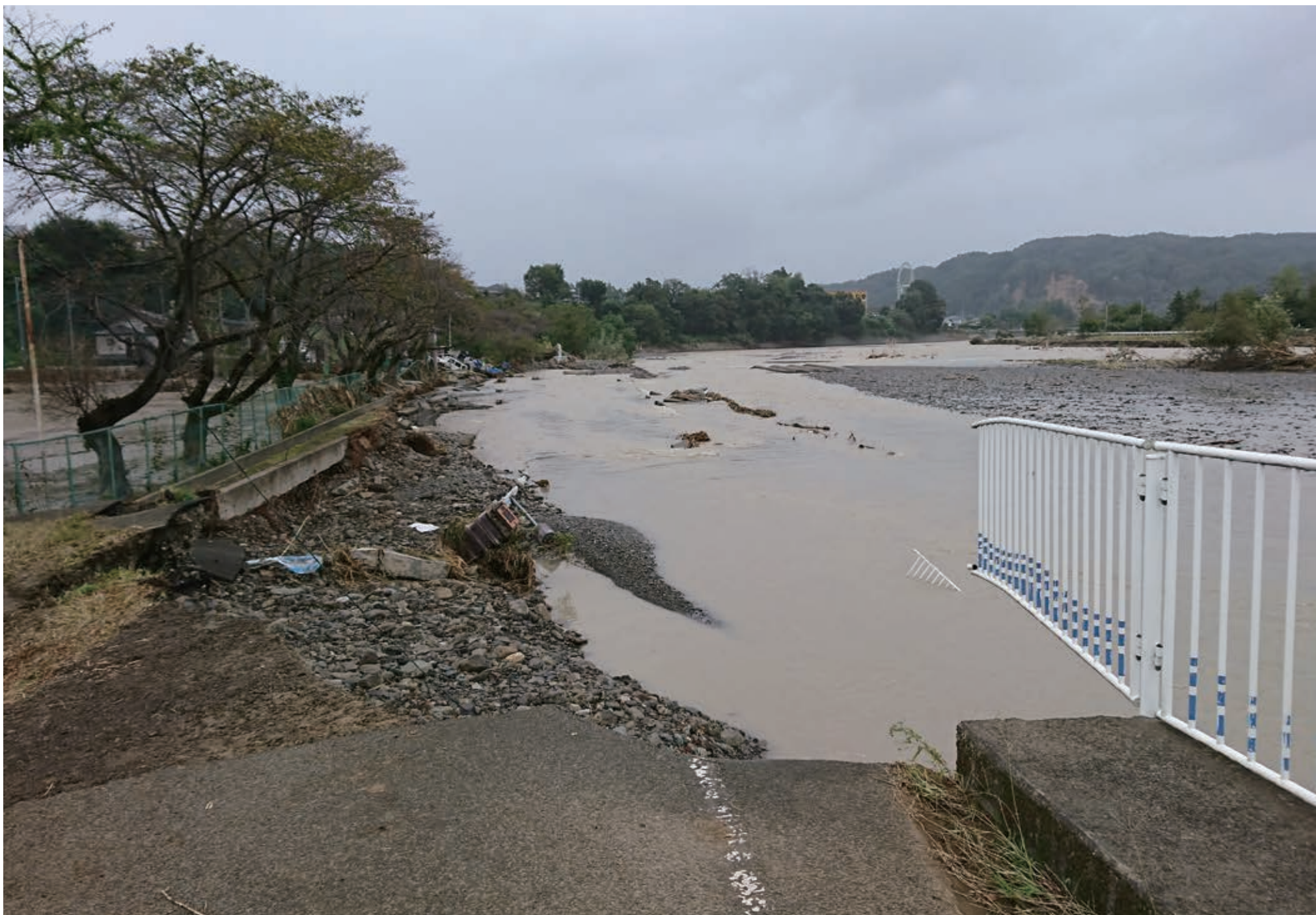
令和元年東日本台風（奥多摩観測所で総雨量 650 mm以上を記録。都管理河川では7 河川が溢水、4 河川で護岸の崩壊が発生） 写真：秋川
