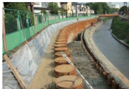
善福寺川 | 河道整備
