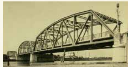
浦安橋(1940年、昭和15年) 千葉県との県境(江戸川) 江戸川区・浦安市
