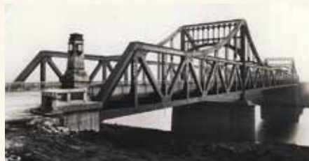
戸田橋(1932年、昭和7年) 埼玉県との県境(荒川) 板橋区・戸田市
