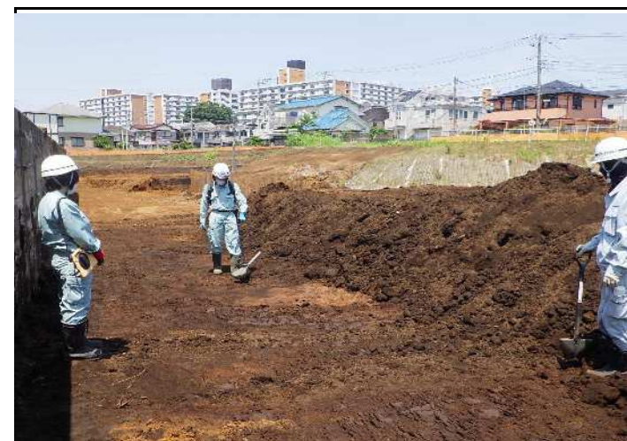
不発弾に対する金属探査状況
