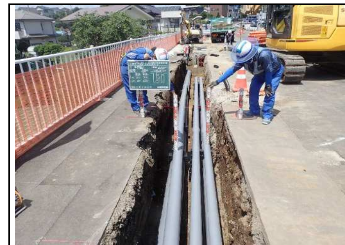
電線共同溝管路設置確認状況
