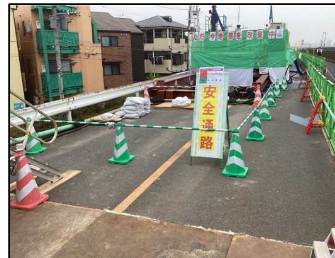
地盤改良施工状況（区道上）
