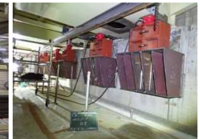
陸橋のジャッキアップ状況
