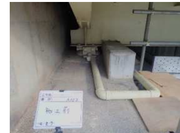
支承取替前状況
