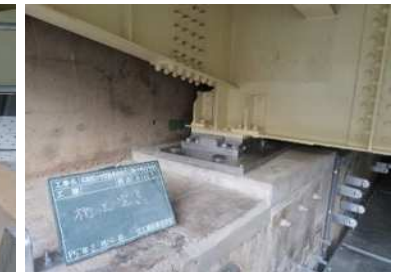
支承取替完了
