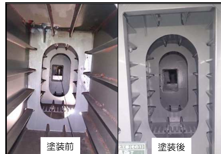
アーチリブ内の狭いダイヤフラム部の塗装前後
