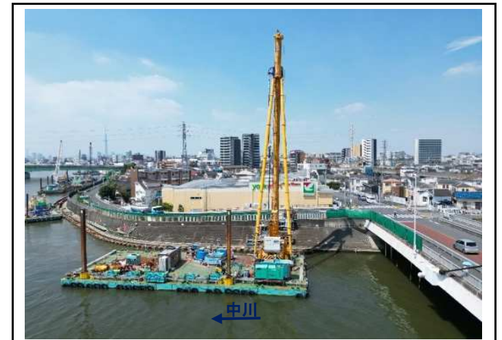
橋梁近接時における地盤改良作業状況
