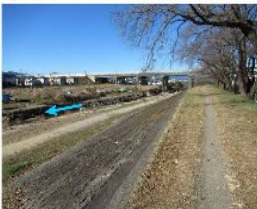
①整備済みの状況
