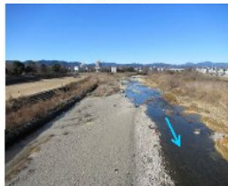
⑫橋を越えより上流を望む
