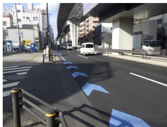
尾久橋通り（荒川区東尾久）
