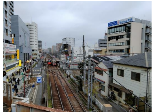
（荒川区町屋一丁目付近）
