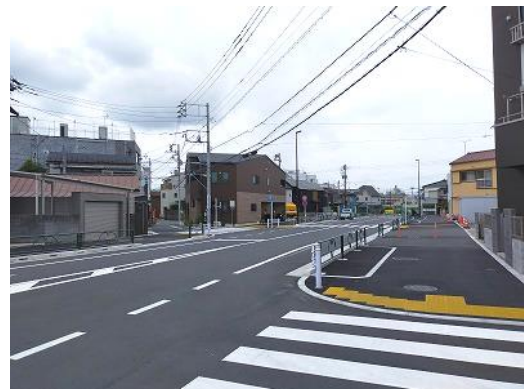
（足立区本木一丁目付近）
