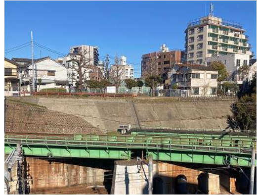
(北区田端側から撮影)
