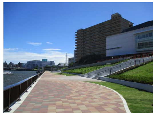
（隅田川スーパー堤防・神谷三丁目地区）
