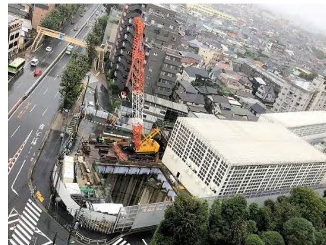
環状七号線地下広域調節池（住宅地の中の工事の様子） 17
