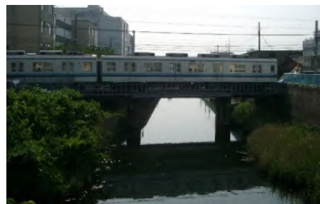
北十間川新小原橋付近（水位低下後）
