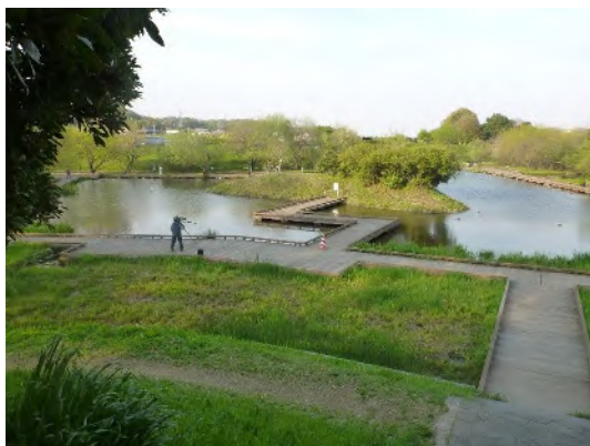
掘込み式（金山調節池）
