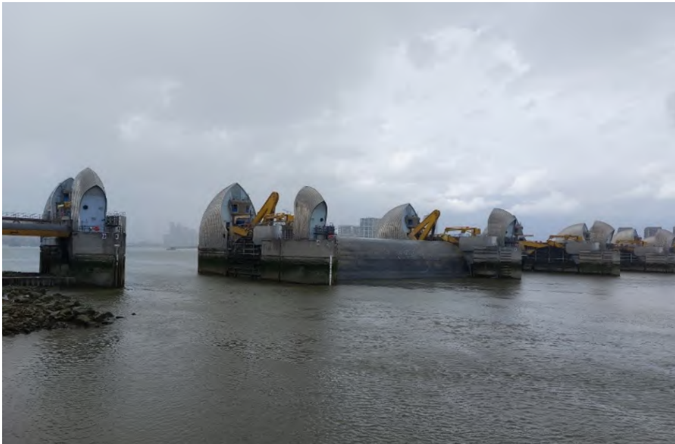
高潮等からロンドンを守るテムズバリア（右岸下流側）
