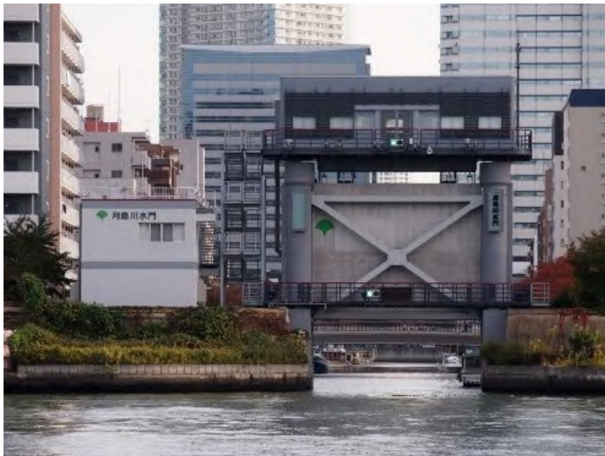
水門、排水機場等の新設・改良
