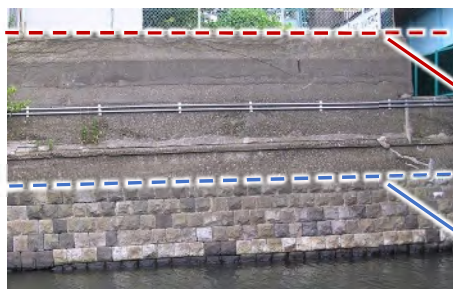
嵩上げ護岸の状況
