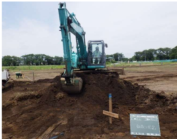
バックホウ掘削
