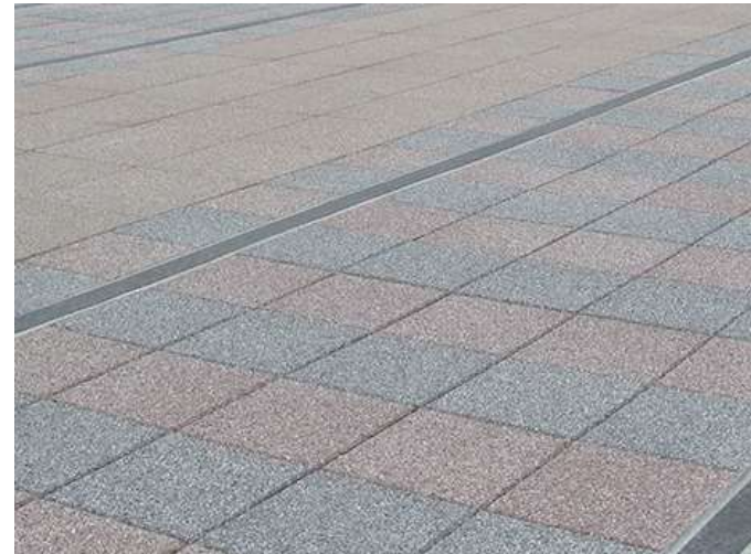
擬石ブロック舗装
