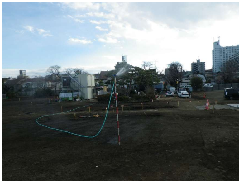
スプリンクラーによる散水状況
