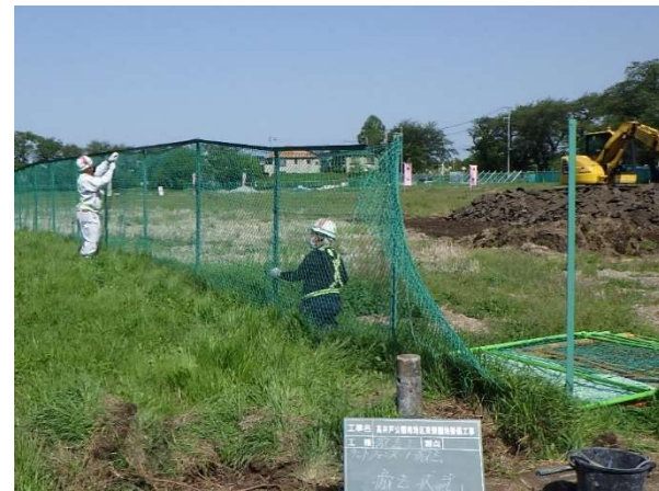
メッシュフェンス撤去
