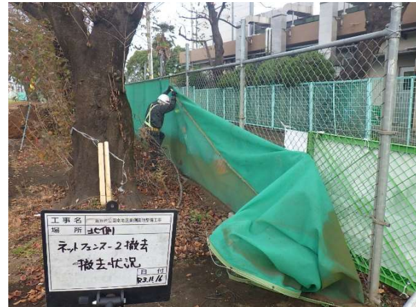
ネットフェンス撤去
