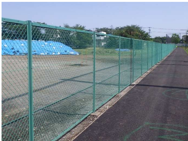
アスファルト舗装撤去
