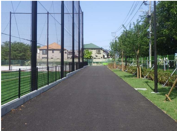
アスファルト舗装
