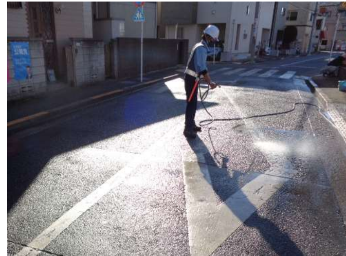
敷地周辺清掃の例
