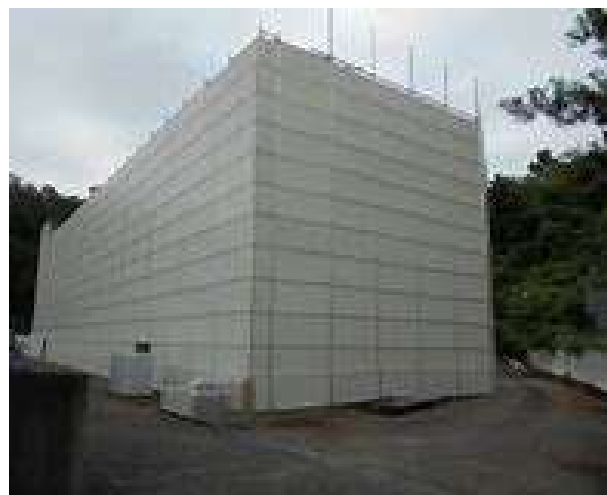
(例) 防音パネル養生
