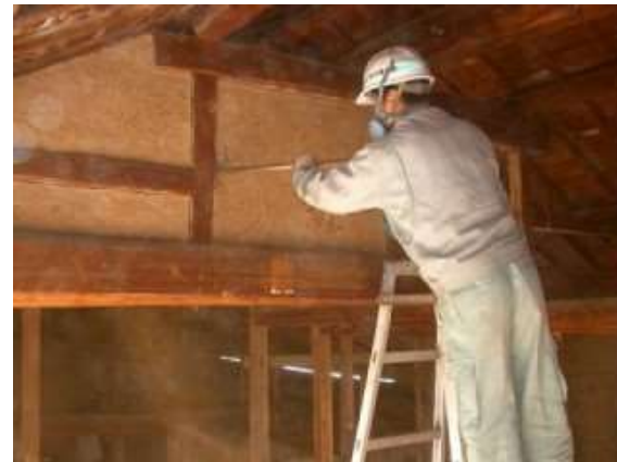
内部造作撤去
