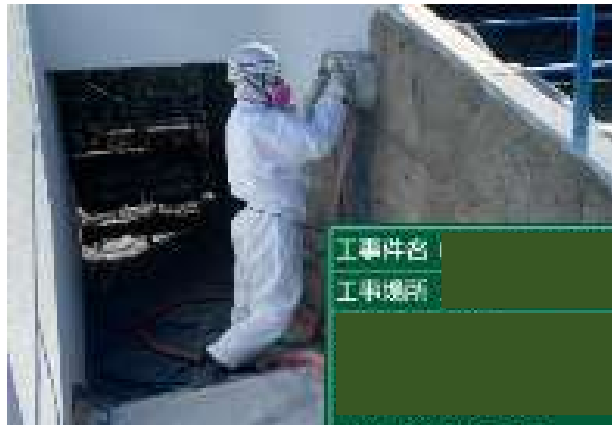
アスベスト除去工事
